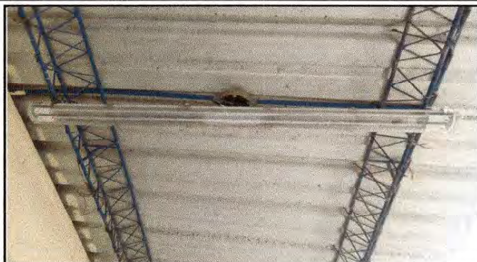
Foto 8: Lámparas en aulas y cocina
