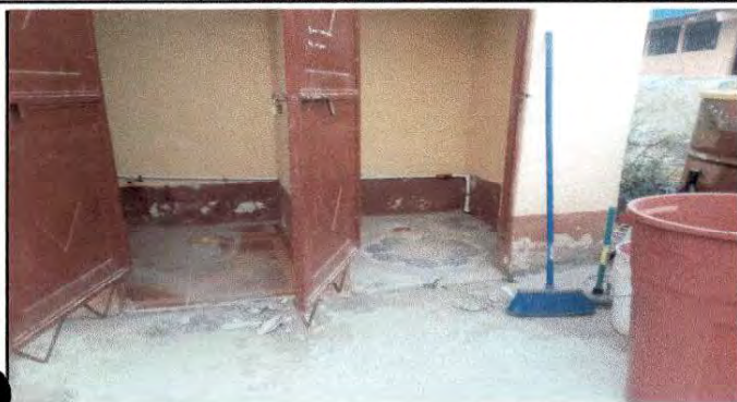
Foto1: Instalación de tazas o sanitarios
