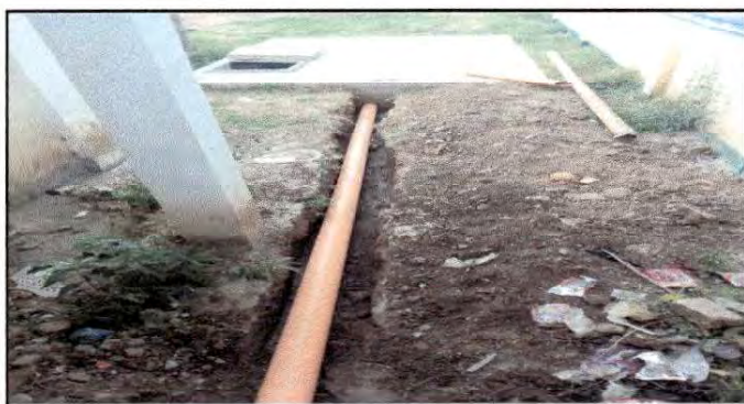
Foto 3: Instalación de drenaje aguas negras
