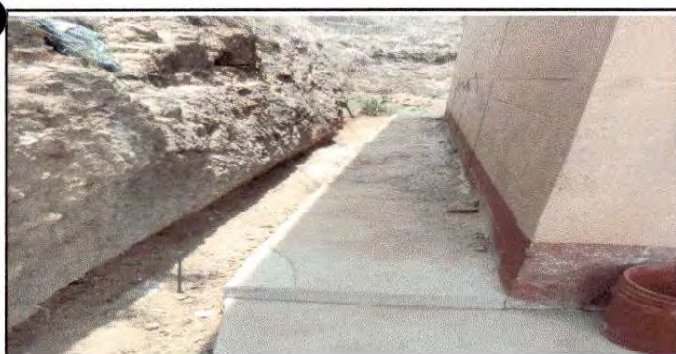
Foto 5: Cuneta de concreto
