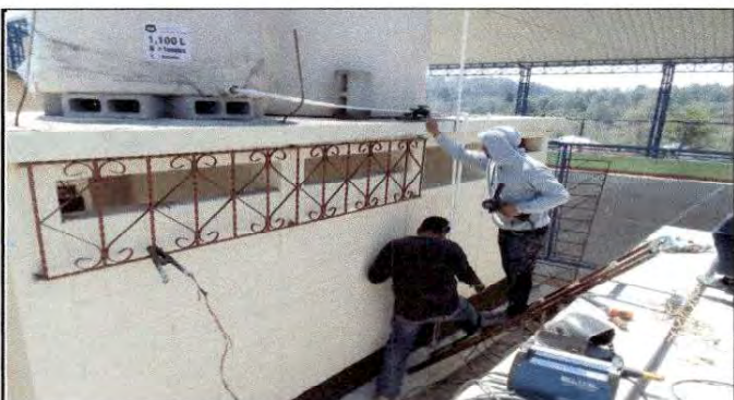
Foto 4: Instalación de balcones en sanitarios
