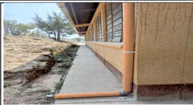
Foto 2: Bajadas de aguas pluviales
