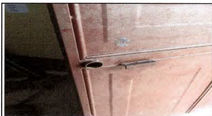
Foto 9: Instalación de chapas en puertas
